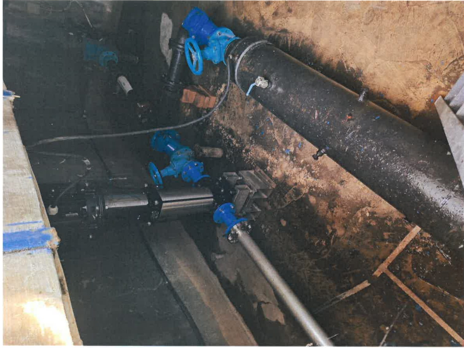
8. kép - Pázmánd települési nyomásfokozó akna [Helyszíni bejárás - 2024.07.09]
